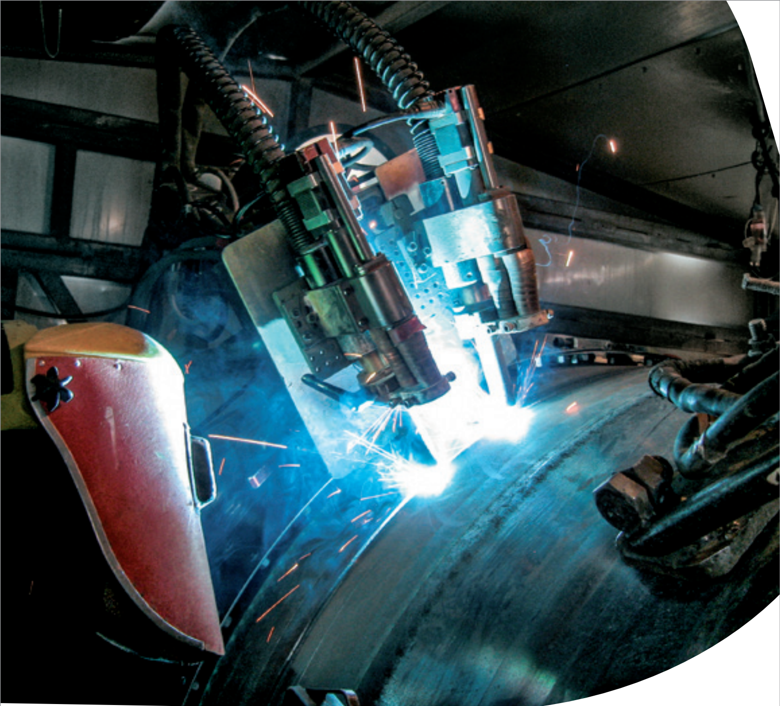
Автоматическая дуговая сварка в среде защитных газов плавящимся электродом
