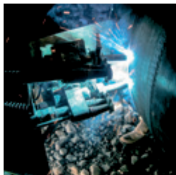
Автоматическая дуговая сварка в среде защитных газов плавящимся электродом
