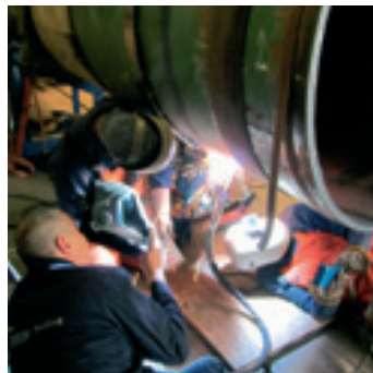
Механизированная дуговая сварка порошковой проволокой в среде защитных газов
