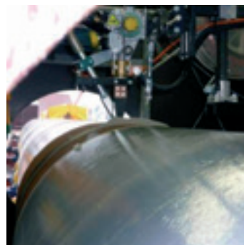
Автоматическая дуговая сварка под флюсом
