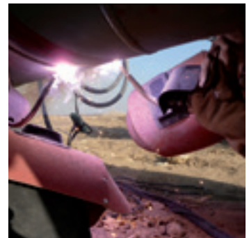
Механизированная дуговая сварка самозащитной порошковой проволокой
