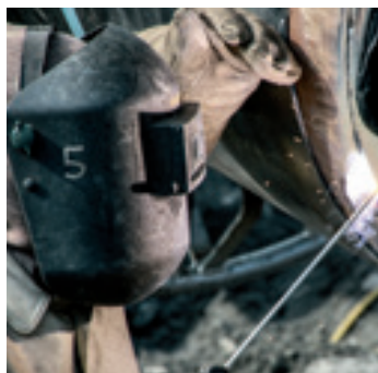
Ручная дуговая сварка покрытым электродом
